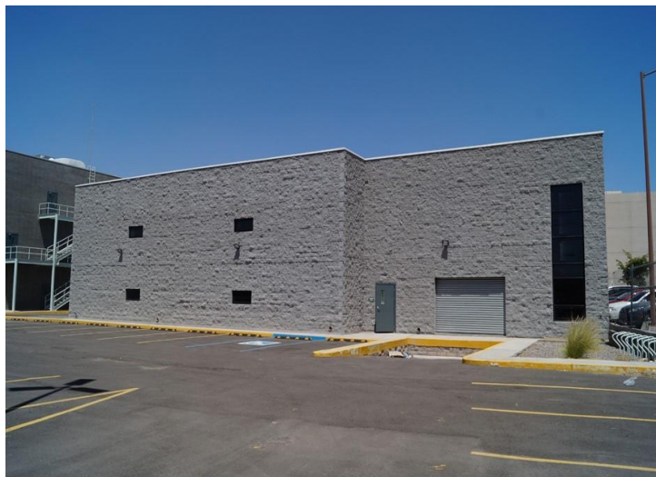
Ilustración 2. Inmueble bodega sujeto.
