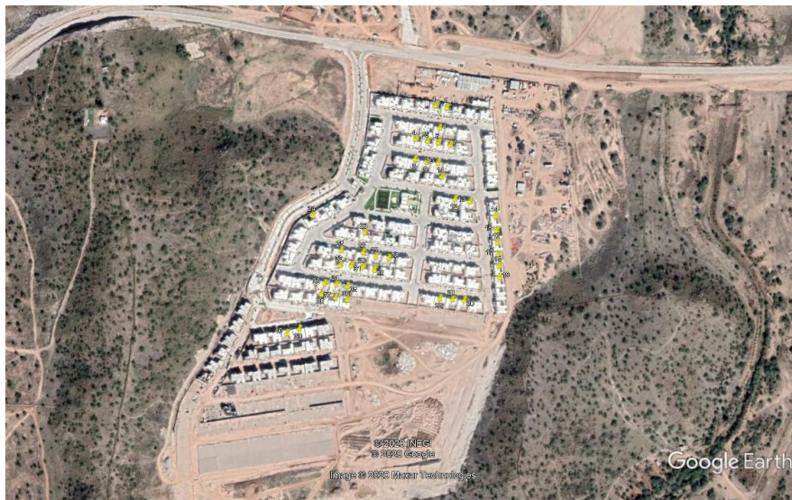
Figura 3.6. La Coruña Residencial.
