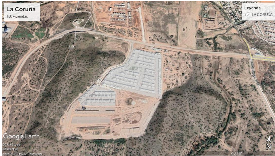
Figura 3.2. La Coruña Residencial.
