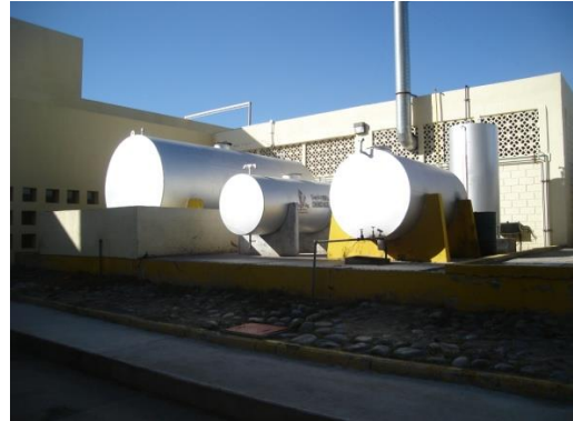
Tanque de Diesel, patio interior, explosión-incendio
