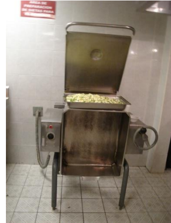
Horno Eléctrico, Cocina, Incendio.
