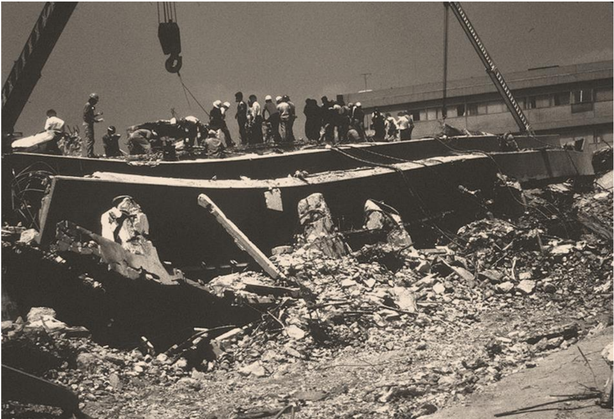
Figura 1.1. Hospital General colapsado en terremoto en la Cd. de México de 1985. Fuente: (USGS, 1985)
