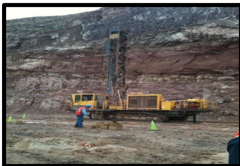
Figura 4.- Rotaria y personal de voladura cargando los barrenos de producción
