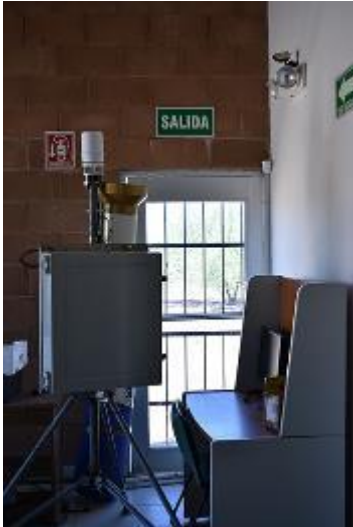
Imagen 19 Salida de emergencia bloqueada
