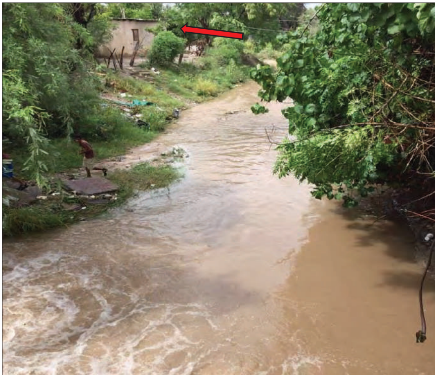
Foto 10. Calle Toboso Amarillo, lámina de agua con altura aproximada de un metro, nótese también el asentamiento urbano a orillas del cauce.
