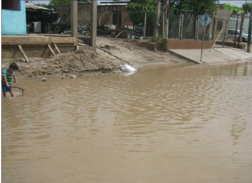
Foto 8. Calle Magnolia, lámina de agua con una altura de aproximadamente 30 centímetros provocada por el pase del cauce principal
